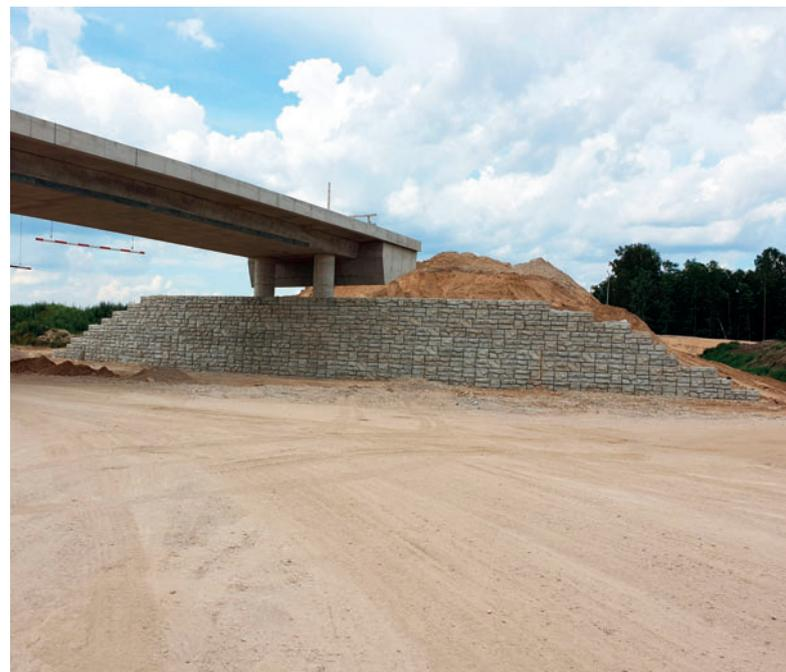
*Planificados originalmente como muros de placas MSE, más de 600 bloques Redi-Rock PC con textura de piedra de mampostería forman los muros de contención para el puente Mustla.*
