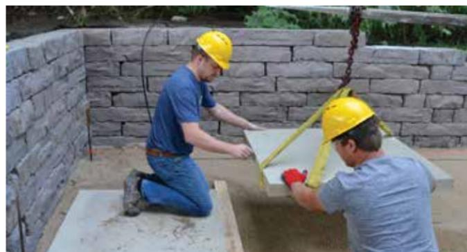
Coloque las lasjas con el dispositivo de alzado de Miros o con correas de nailon con la tensión adecuada
