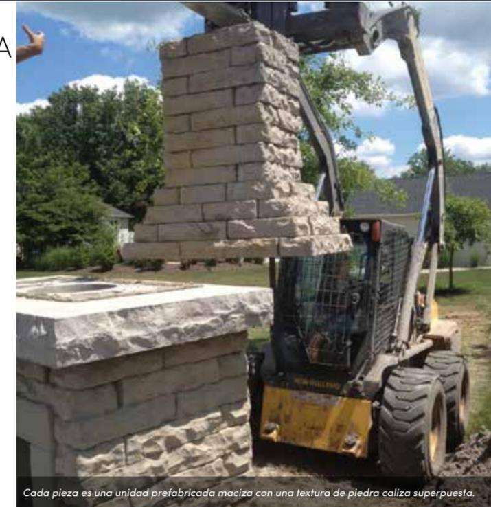
Cada pieza es una unidad prefabricada maciza con una textura de piedra caliza superpuesta.
